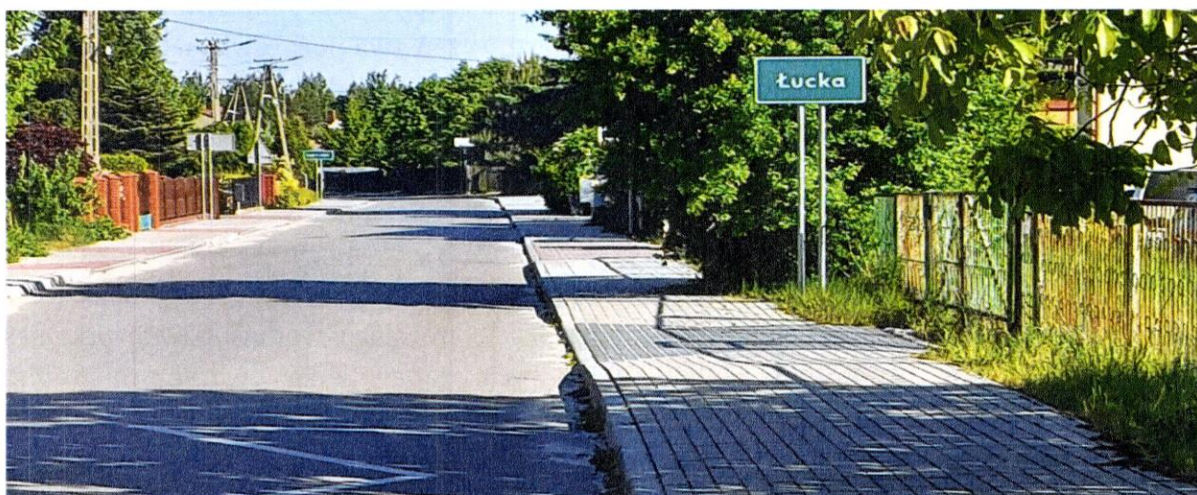
Rysunek 14. Modernizacja chodnika w ciągu drogi gminnej nr 103413L w miejscowości Łucka
