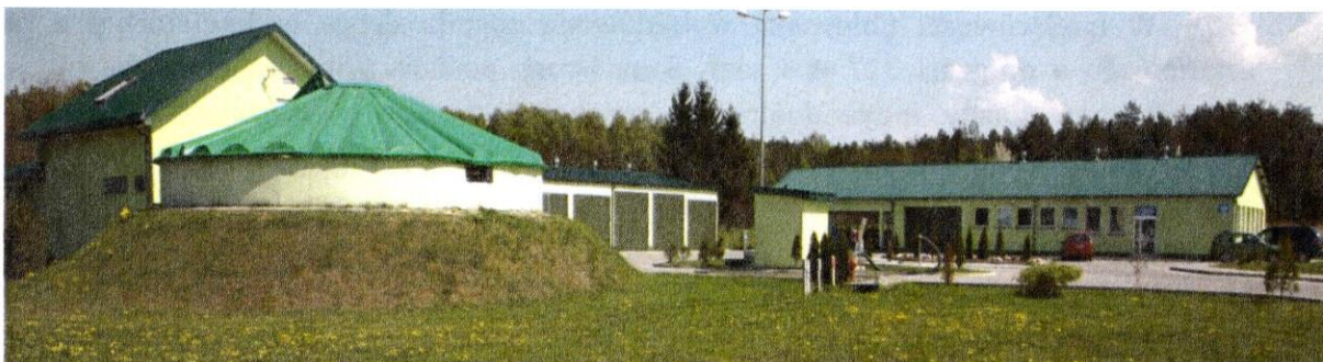
Rysunek 4. Oczyszczalnia ścieków w Skrobowie-Kolonii
