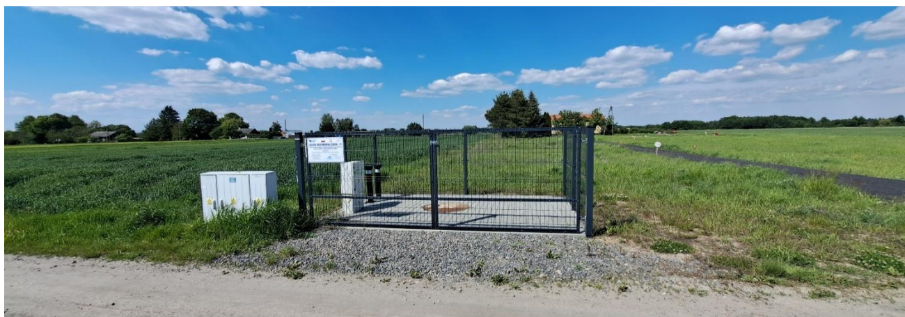
Przepompownia ścieków P3 w Skrobowie.
