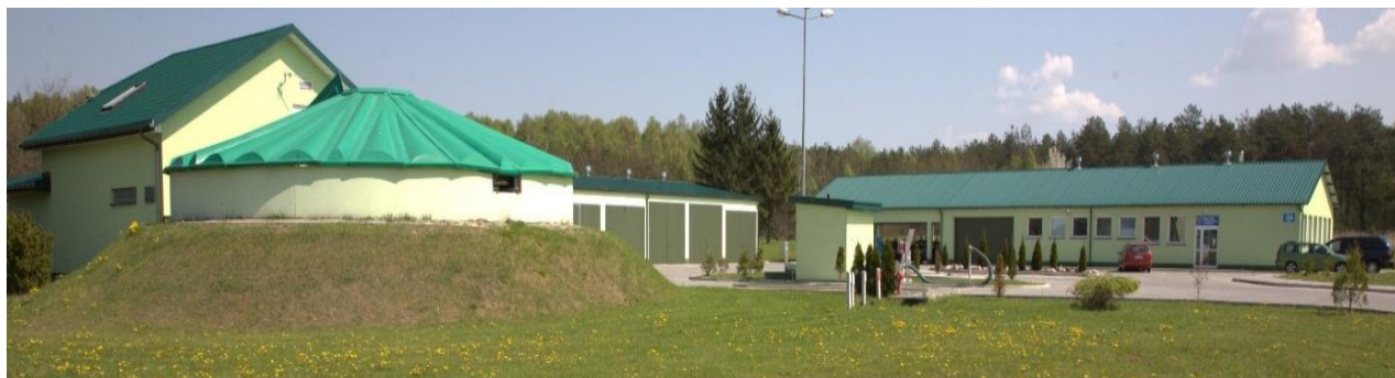
Oczyszczalnia ścieków w Skrobowie-Kolonii
