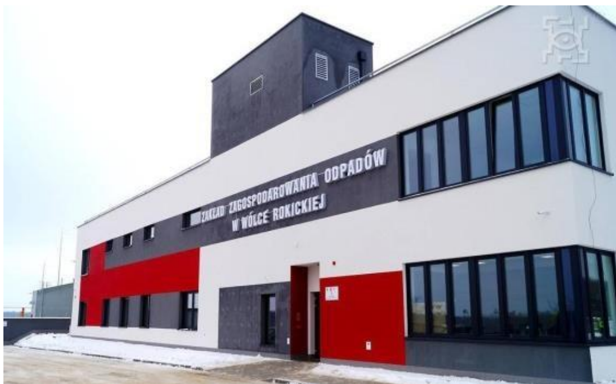
Zakład Zagospodarowania Odpadów w Wólce Rokickiej
